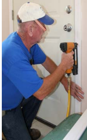
Un voluntario instala un marco nuevo para una puerta en un hogar dañado en Slidell, Louisiana. Foto: Matt Hackworth/CWS
